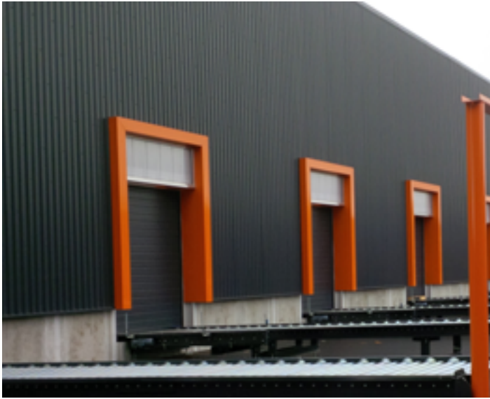
Lignes de stockage automatiques piles de palettes vides
